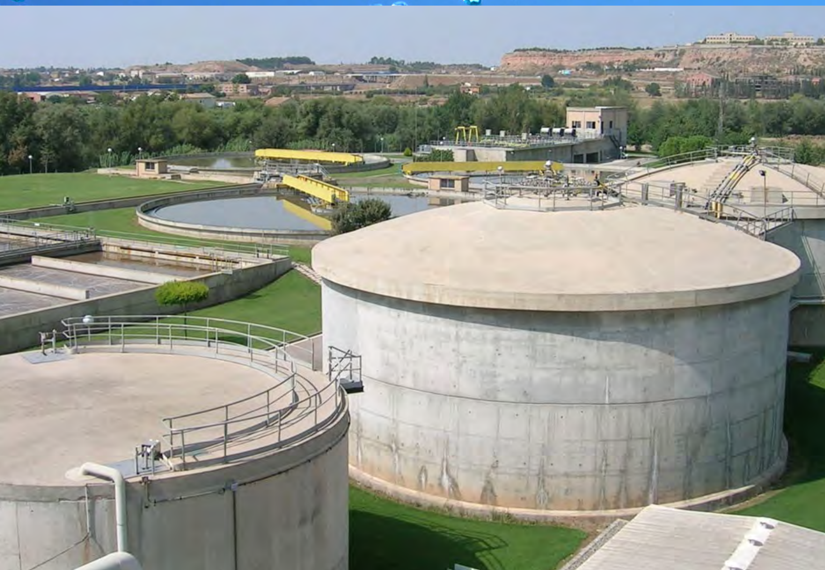
Lleida Wastewater Treatment Plant (Catalonia).
